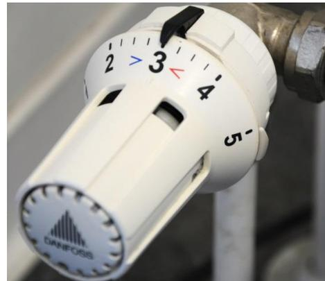
Thermostatventil zur Regelung der Raumtemperatur
